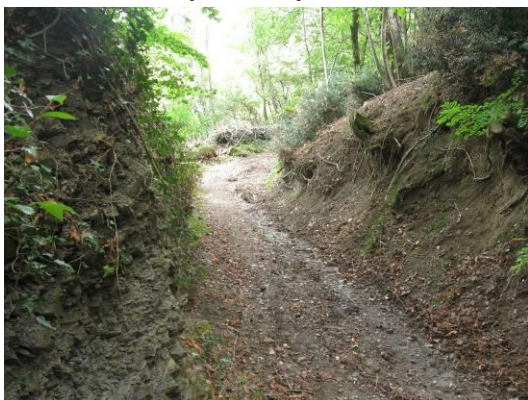
Slika 7,8: Obstoječe stanje cesta v strmem vkopnem delu. Tvorjenje erozijskega odvodnega jarka ob desni brežini.
