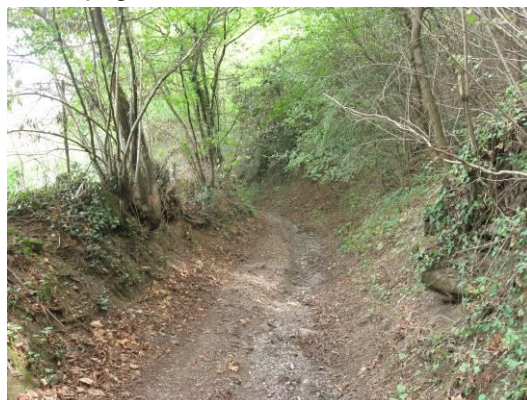
Slika 7,8: Obstoječe stanje cesta v strmem vkopnem delu. Tvorjenje erozijskega odvodnega jarka ob desni brežini.
