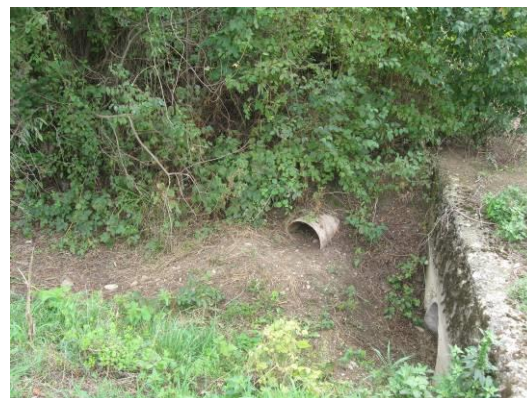
Slika 9,10: Zaključek obdelovalnega odseka ob obst. prepustu na jarku, delno zasut iztok obstoječe meteorne kanalizacije.
